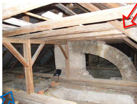
Obr. 3 Pohľad na krov
