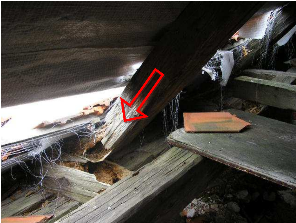
Obr. 7-9 Hniloba a rozpad častí väzných trámov a krokiev
