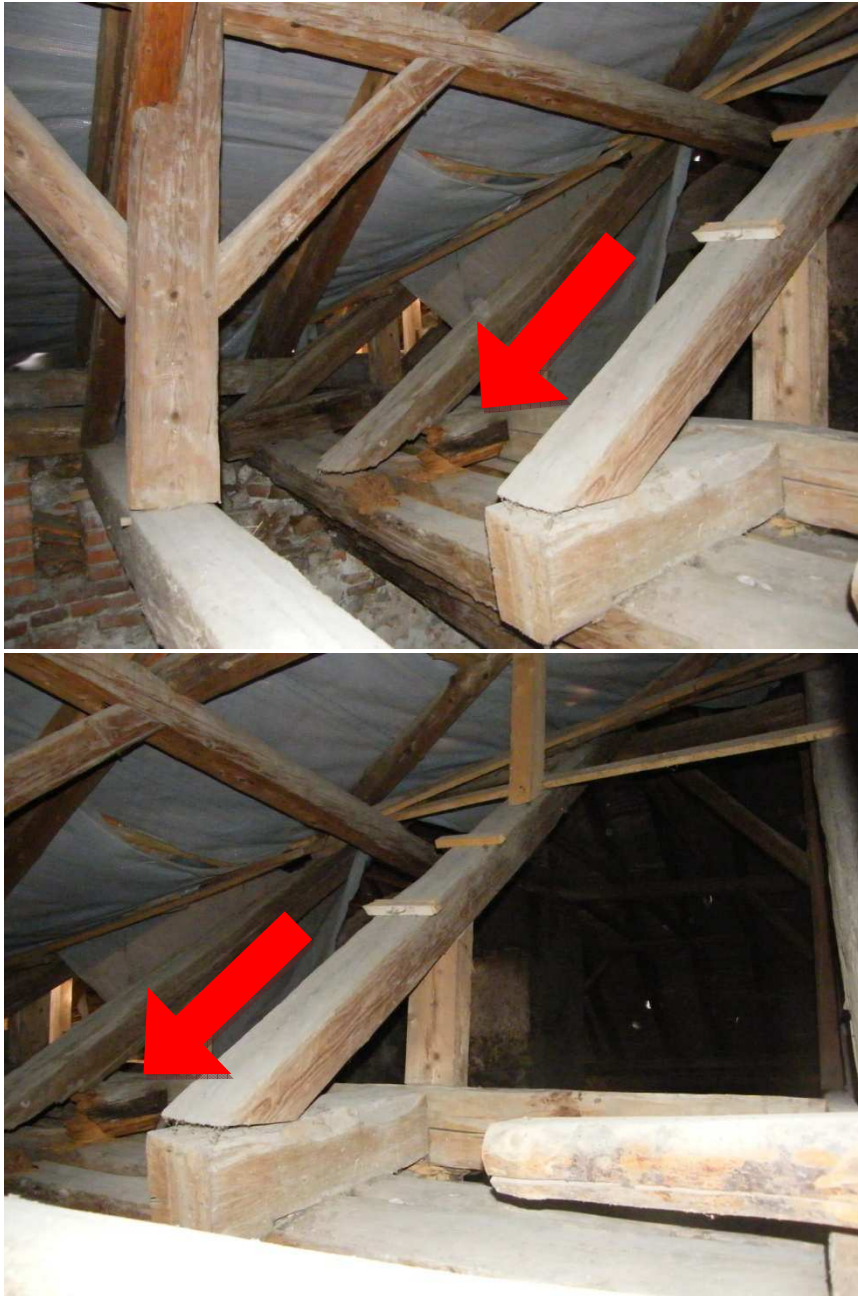
Obr. 10-11 Spráchnivenie a rozpad väzného trámu
