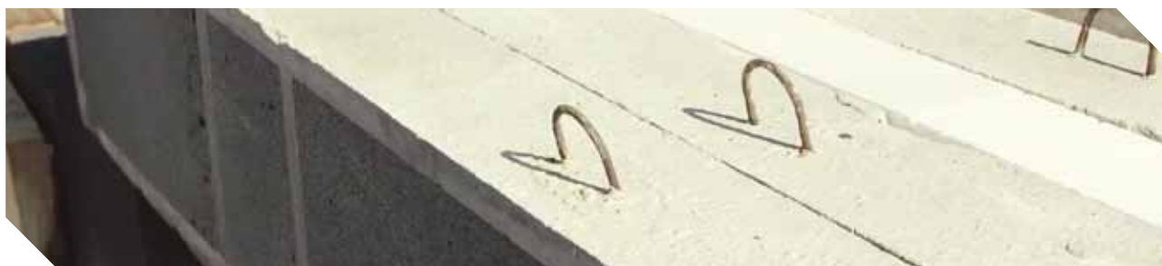
vyskladaný nosný preklad - šírka múru 375 mm
